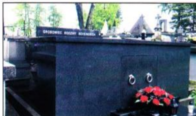
Grobowiec Beksińskich ma styl typowy dla wschodniej Lubelszczyzny, Kielecczyzny i Podkarpacia: wyrasta wysoko ponad podłoże, a trumny składa się do niego przez otwór od frontu.
