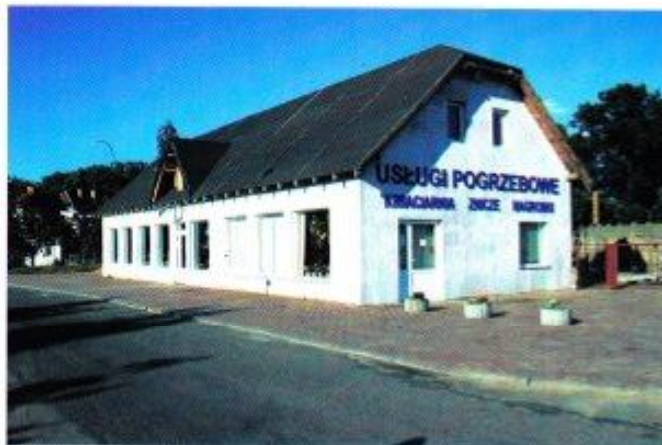
Kolejny obiekt na ukończeniu, w którym powstaje główna siedziba przedsiębiorstwa.
